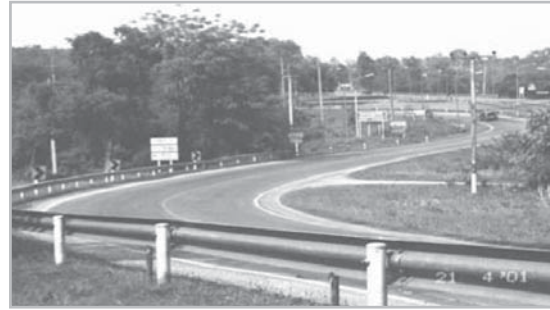
รูปที่ 3-2 ทางโค้งรัศมีแคบ
