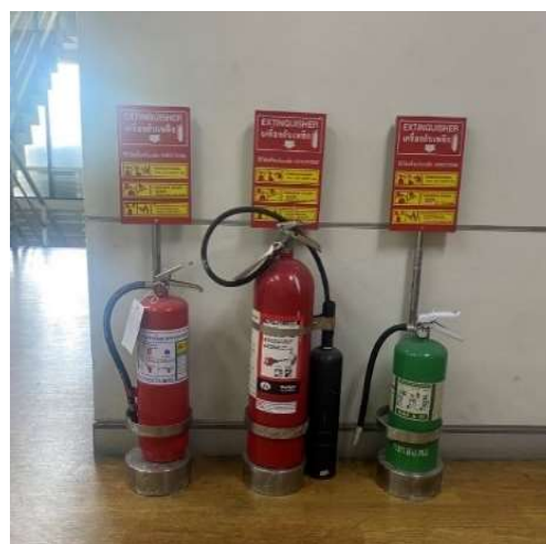
ภาพประกอบที่ ๔.๒ การติดตั้งเครื่องดับเพลิง
