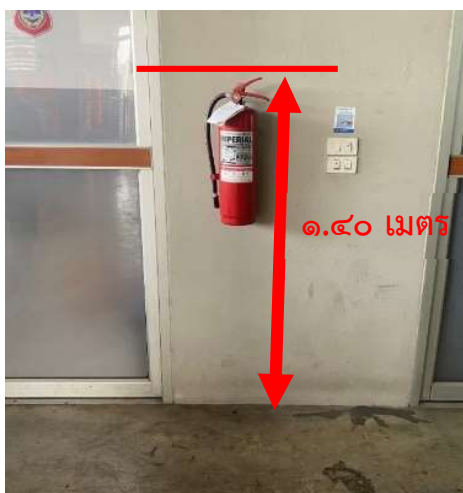
ภาพประกอบที่ ๔.๒ การติดตั้งเครื่องดับเพลิง
