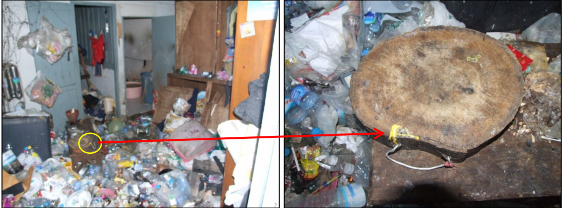
รอยน้ำตาเทียนในห้องครัวใกล้จุดเพลิงไหม้
